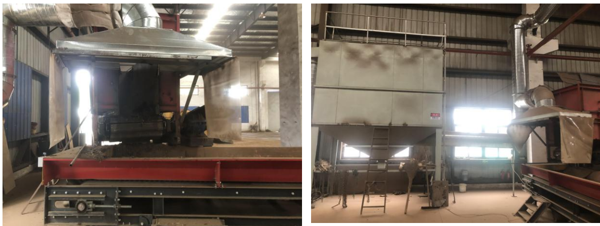
废气收集+除尘设施
